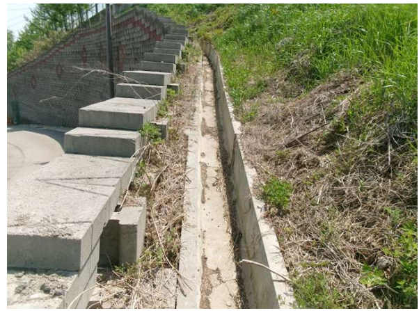
상부 배수로 전경
