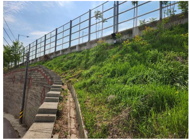
상부 성토부 전경
