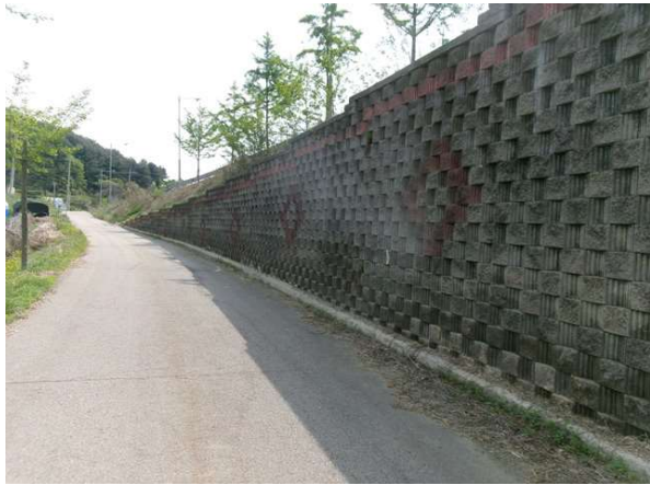
하부 지방도 전경
