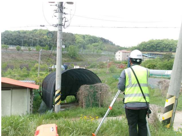
광파기를 이용한 측량 작업
